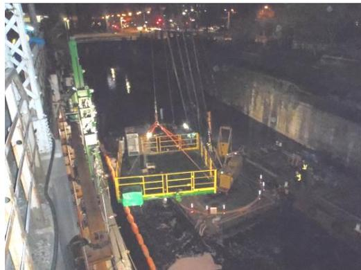
写真-3 クレーン台船による架設
