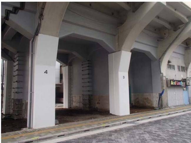
写真 1 高架橋柱湾曲部(補強後)
