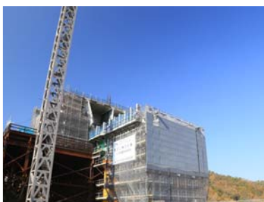
写真-2 柱頭部押出し前
