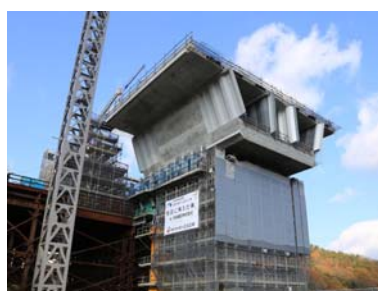
写真-3 柱頭部押出し後
