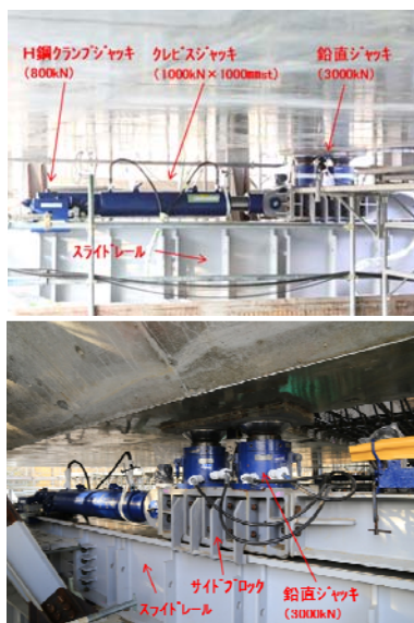
写真-1 ジャッキシステム
