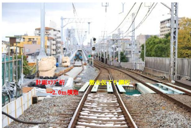
写真-1 切替直前横取完了
