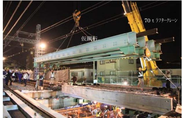
写真-2 仮鋼桁撤去状況
