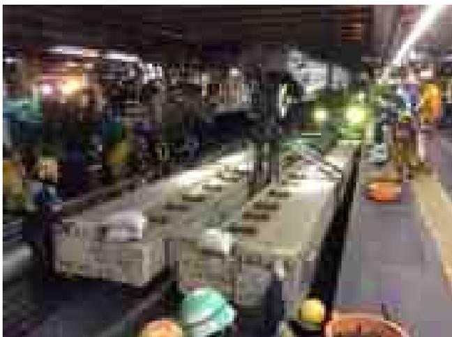
写真-1 PC 工事桁撤去状況
