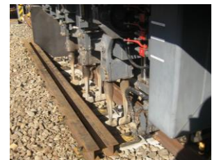
写真-3 MTT 施工可能状況
