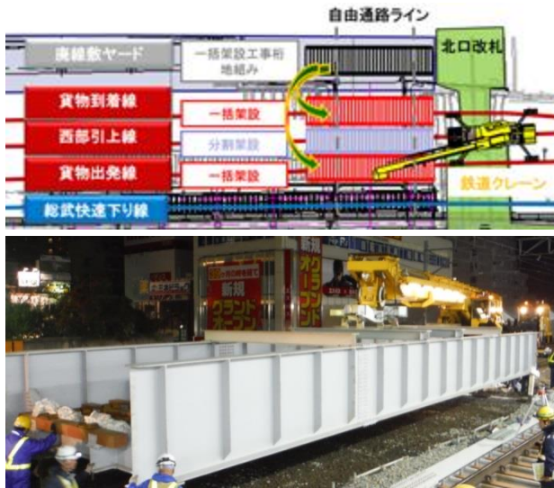
図-3 工事桁一括架設
