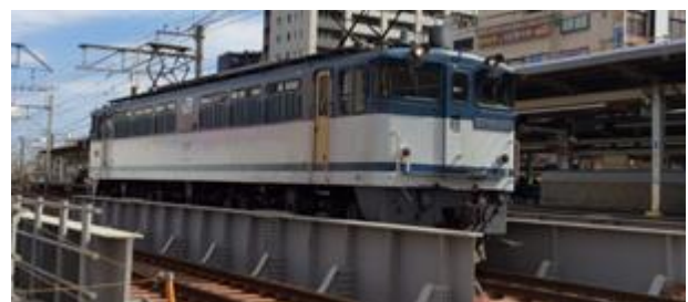
図-7 貨物線工事桁架設完了
