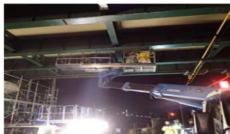
写真. 5 主桁間への進入と横桁の抱き込み
