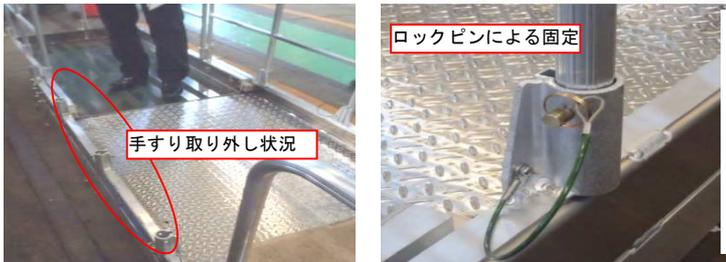
写真.1 手すり取り外し・固定状態
