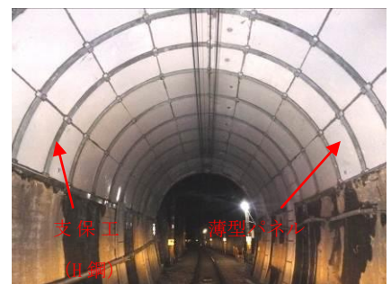
写真-3 補修工の完了
