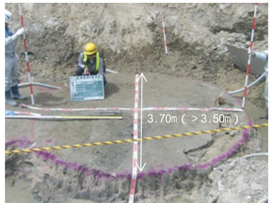
写-2 試験施工写真(改良径確認)
