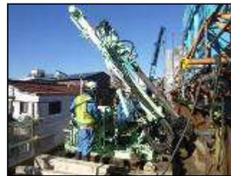
写真-4 拡径アンカー施工状況
