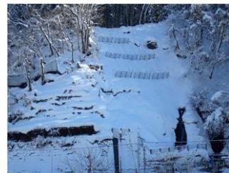
写真-4 吊式なだれ止め柵
