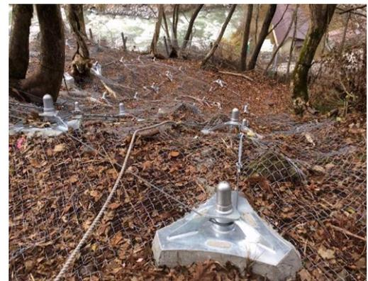
写真-7 ノンフレーム工法
