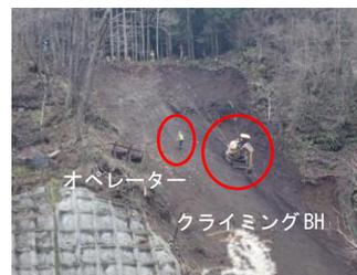
写真-2 クライミングバックホウによる不安定土塊撤去
