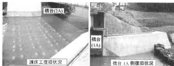
図 - 10 護床工及び橋台 1A 側復旧状況
