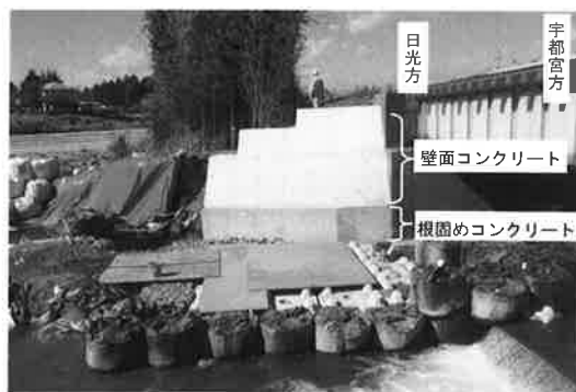
図 - 9 翼壁流出箇所の復旧状況
