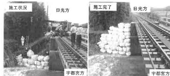
図 - 7 土のう設置状況
