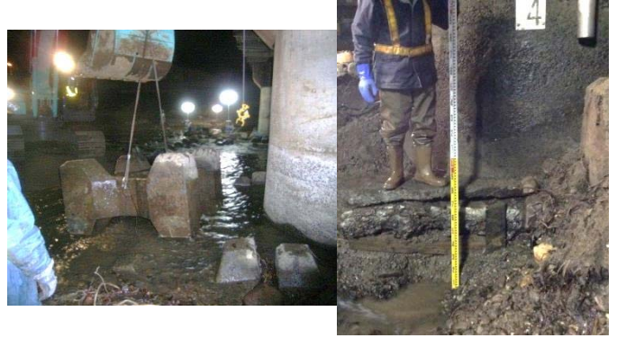
写真2 根固めブロック撤去状況
