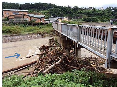
写真1 流木集積状況
