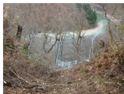
写真 4 待受け対策工設置状況
