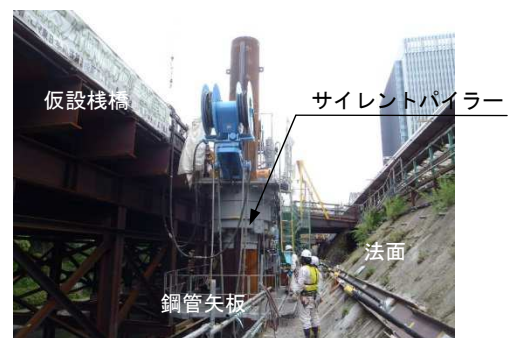
写真-1 鋼管矢板（測点7付近）
