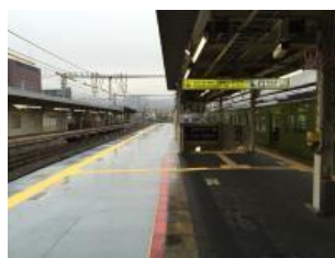
図-6 仮設ホーム切替後
