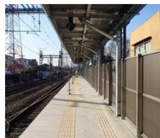
写真-4 ホーム舗装
