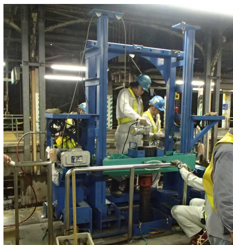
図-4 杭圧入の様子
