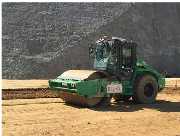
写真-3 自動転圧作業中の振動ローラ
