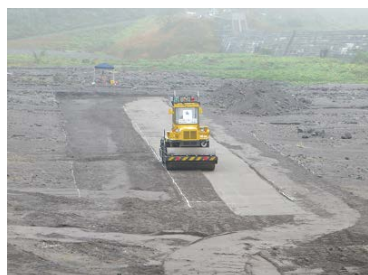
写真-2 直進性の検証状況
