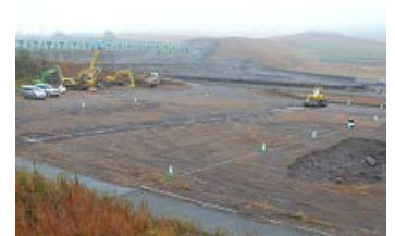
写真-1 検証実験状況
