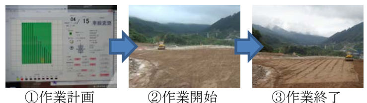
図-1 自律制御型振動ローラ操作ステップ
