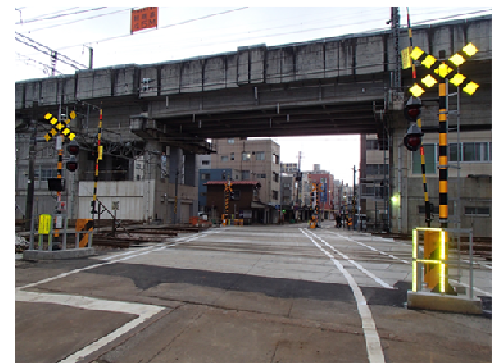
写真-1 現場状況
