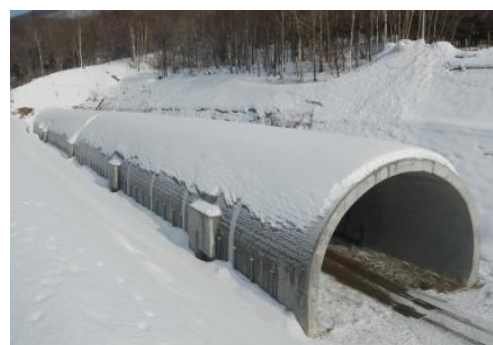
写真-3 巻出工完成
