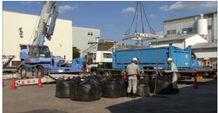
写真-1 大型土のうの荷台への積み込み作業
