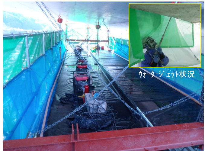
写真-5 ラック足場内 シート防水状況
