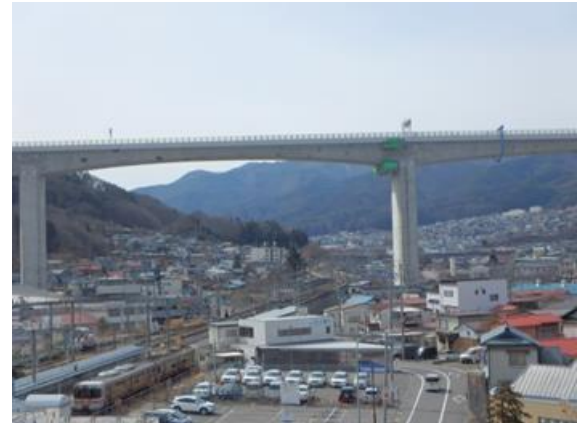
写真-1 当該高架橋 全景
