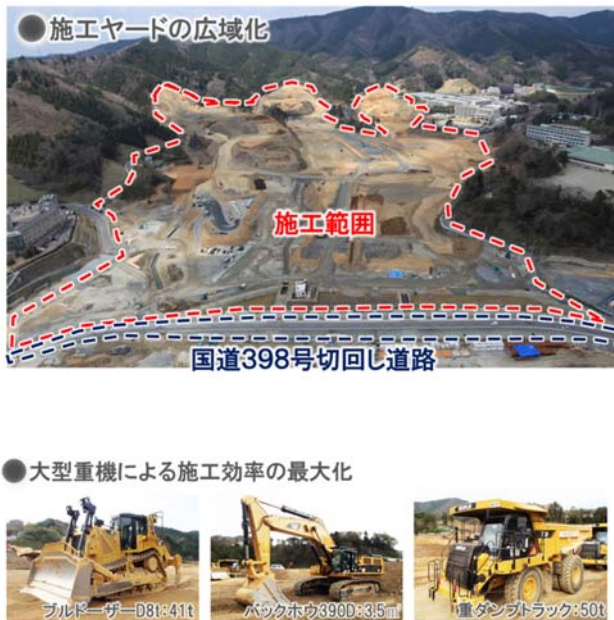
図-4 造成エリアの締切と大型重機
