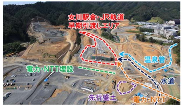
図-5 他工事との調整の様子
