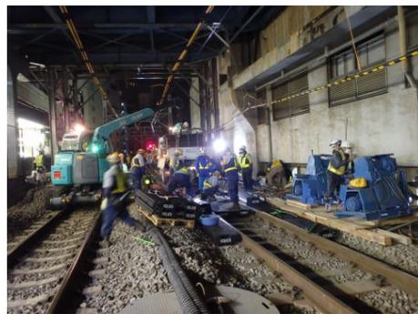
写真 1 薬液注入施工状況
