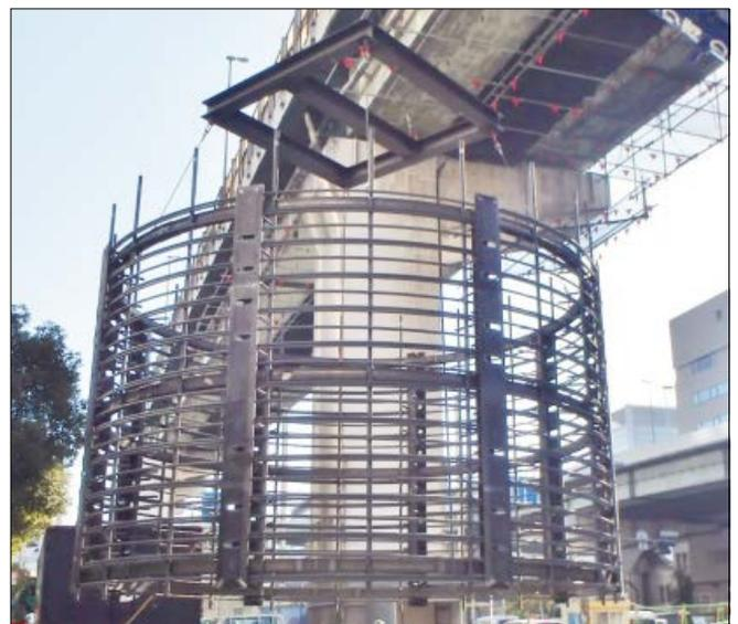
図-4 底版鉄筋かご建込み状況写真
