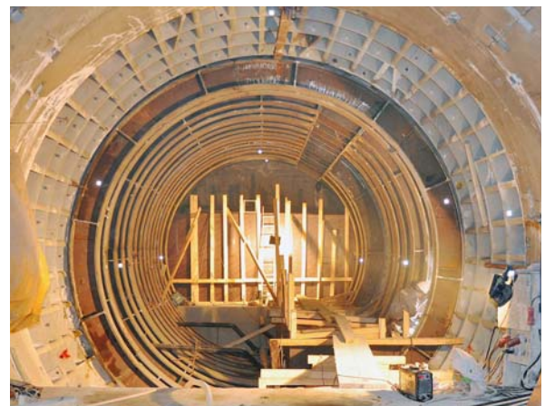
写真 1 NE-ISS 交差部施工状況 (NE トンネル側)
