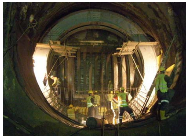
写真 2 NE-ISS 交差部施工状況 (ISS トンネル側)
