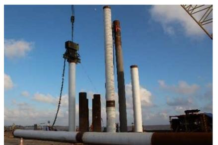
写真-2 油圧パイプロハンマ(10E1412)による打込み(250t クレーン使用)
