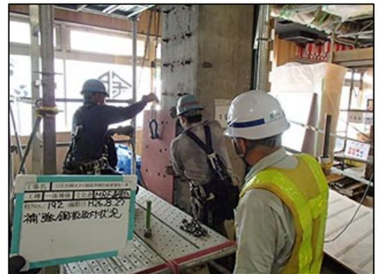
写真-1 1面鋼板取付状況
