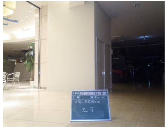
写真-2 軽鉄・石膏ボード仮囲い
