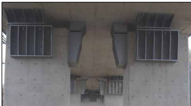
写真-1 支承部補強の例
