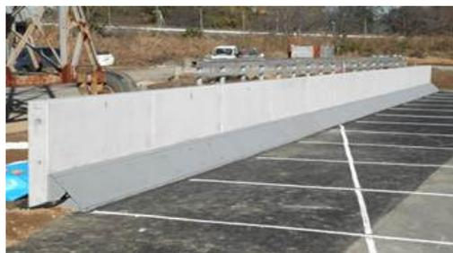
写真 1 PCa 高欄設置状況 (条件 A)
