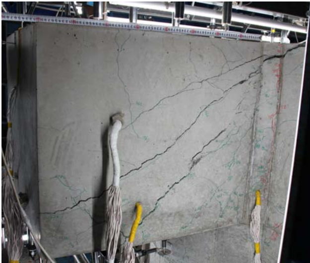
写真-1 梁表面のひび割れ状況 (1-T)
