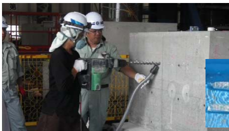
写真-3 ハンマードリルでの削孔状況
