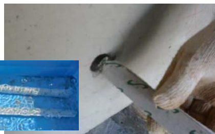
写真-4 SNBカプセルの浸漬・挿入
