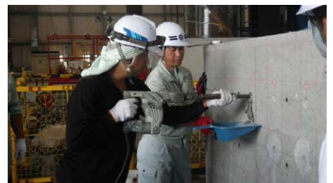
写真-5 SNBの打込み
