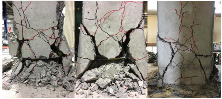
図-4 載荷後の損傷状況(左:No.1 中:No.2 右:No.3)
