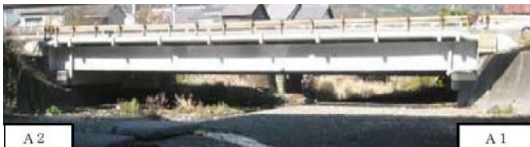
写真-1 対象橋梁
