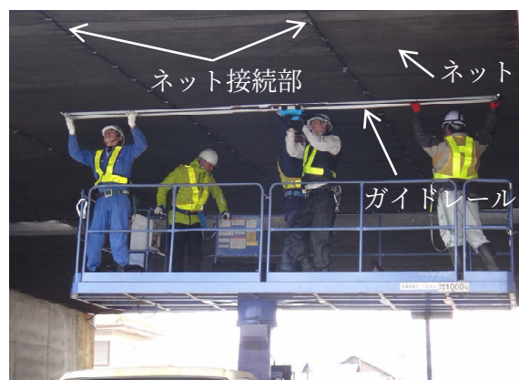
(3)高所作業車デッキ上での作業状況
