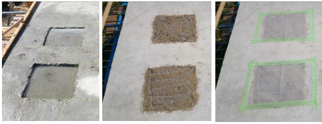
写真-2 供試体施工状況写真 (左から、箱抜き状況、破砕材埋め戻し、カバー)
