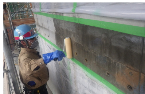
写真-1 養生剤塗布状況
