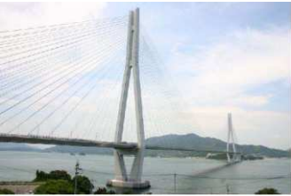
写真-2 多々羅大橋
