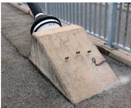
写真-3 斜材定着部試験箇所
