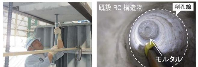
専用注入ホースによる充填 充填直後の孔内状況(上向き)
