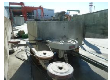
写真-1 切断状況
