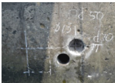
写真-1 鉄筋腐食調査事例
