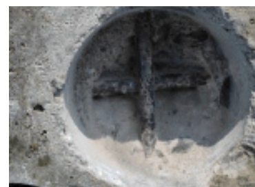
写真-1 鉄筋腐食調査事例
