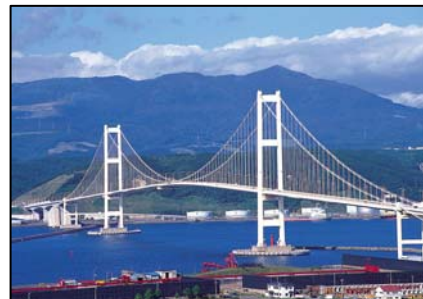
写真-1 白鳥大橋
