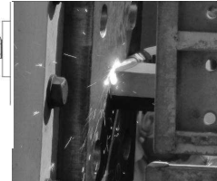
写真-2 切断状況
