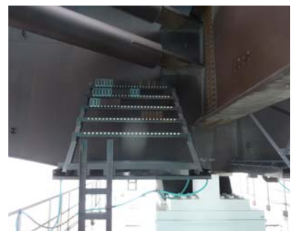
図2 架設位置と暴露試験状況
