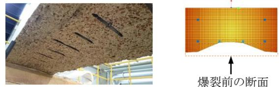
写真-2 爆裂状況 図-3 B断面解析モデル
