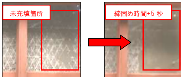
写真-4 締固め時間追加による充填状況
